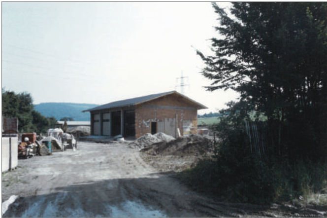
1986: Fertiggestellter Rohbau der Garagen
