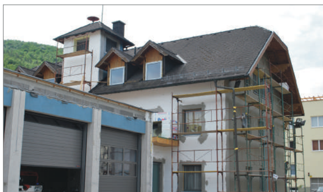
2009: Thermische Sanierung des Wohngebäudes
