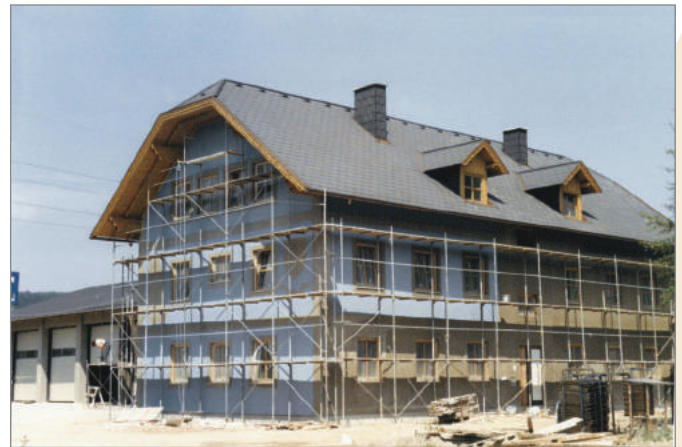
1986-1987 Bau des Feuerwehrhauses
