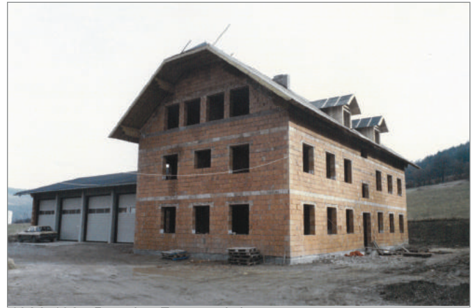
1986-1987 Bau des Feuerwehrhauses
