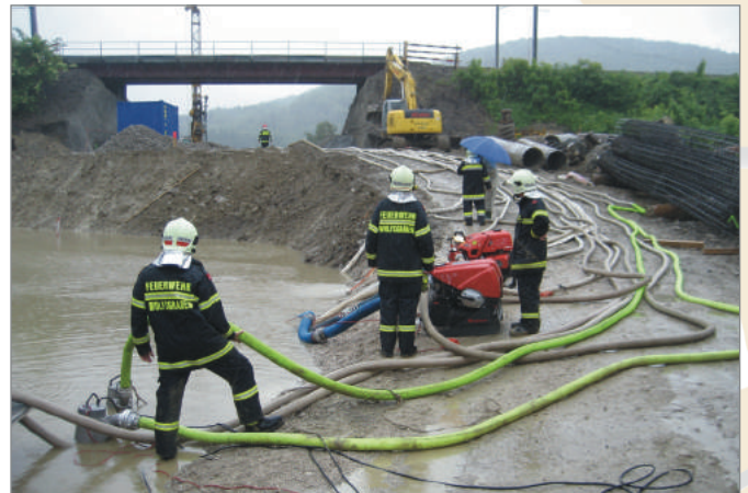
2013: Auspumparbeiten in Pressbaum
